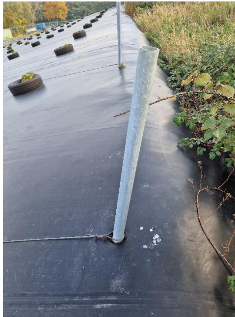
Abbildung 1: Haltestangen an der Abdichtungsfolie
